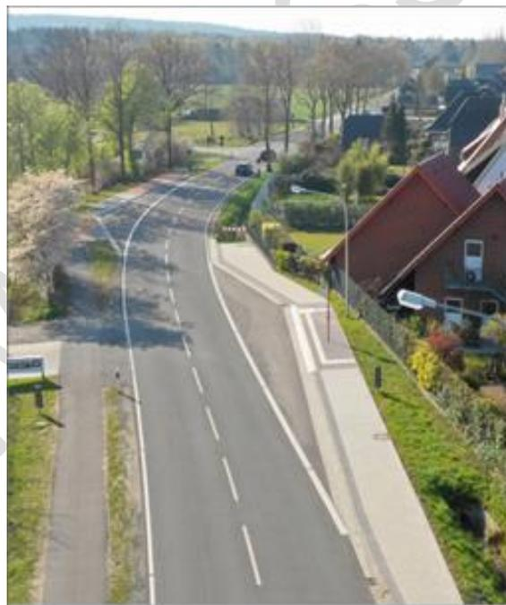
Abbildung 10: Haltestelle Bramsche-Hesepe, Bahnübergang B218 als Beispiel für eine Busbucht nach dem Sägezahn-Prinzip (Quelle: eberhard - die ingenieure gbr)
