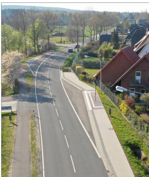
Abbildung 3-21: Haltestelle Bramsche-Hesepe, Bahnübergang B218 als Beispiel für eine Busbucht nach dem Sägezahn-Prinzip (Quelle: eberhard - die ingieure gbr).
