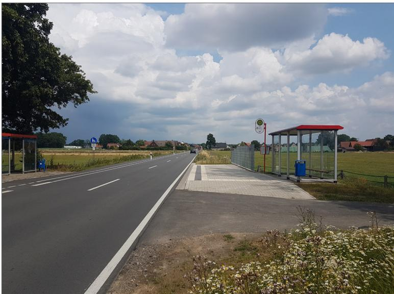
Abbildung 3-20: Haltestellen Jегgen West in Bissendorf nach dem Ausbau als Beispiel für eine Straßenrandhaltestelle.
