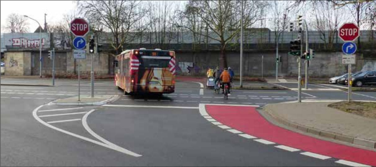
Abbildung 3-23: Beispiel zur Busbeschleunigung an der Kreuzung Bramscher Straße/Hansastraße in Osnabrück.
